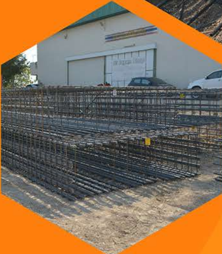
งานติดตั้งเสาเข็มเจาะ แบบเหลี่ยม
