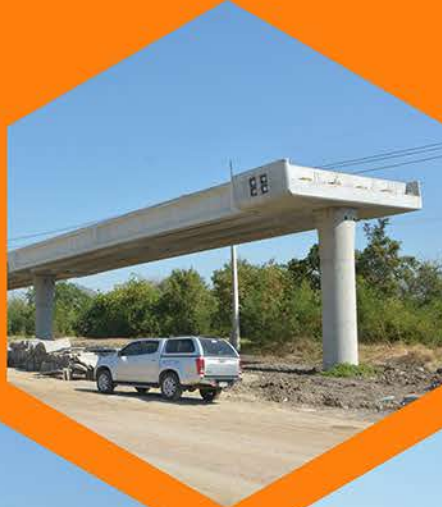
งานก่อสร้าง สะพานข้ามทางรถไฟรูปตัวยู
