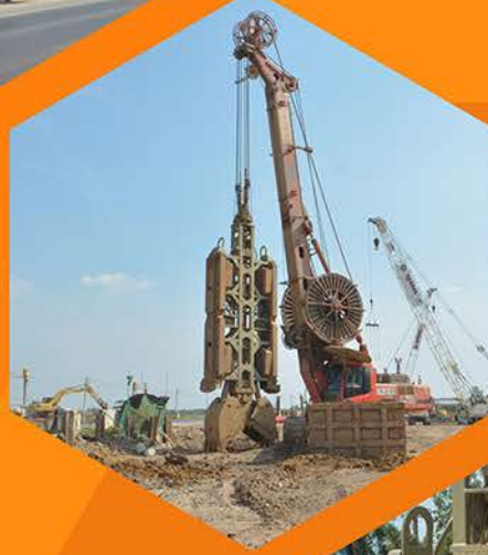
งานเสาเข็มเจาะ แบบเหลี่ยม
