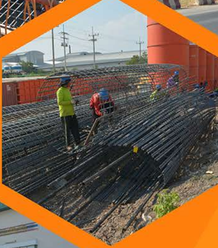
งานเสาเข็มเจาะ แบบกลม
