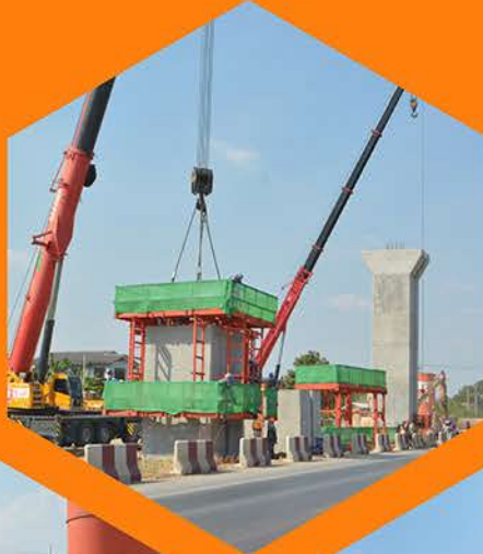
งานติดตั้งเสาทางวิ่ง รถไฟยกระดับ
