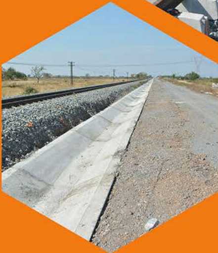
งานก่อสร้างท่อ และทางระบายน้ำ
