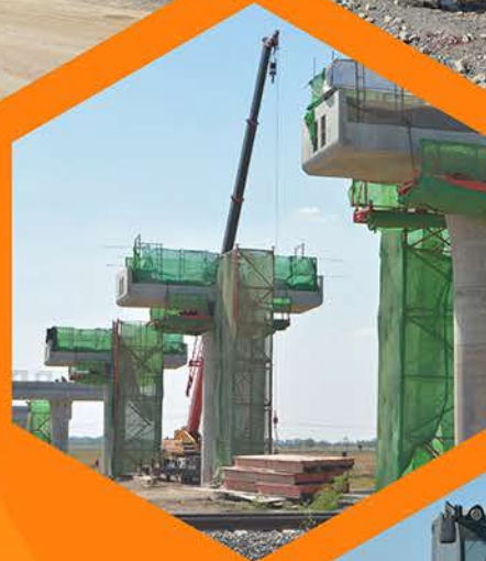
งานก่อสร้าง สะพานข้ามทางรถไฟ
