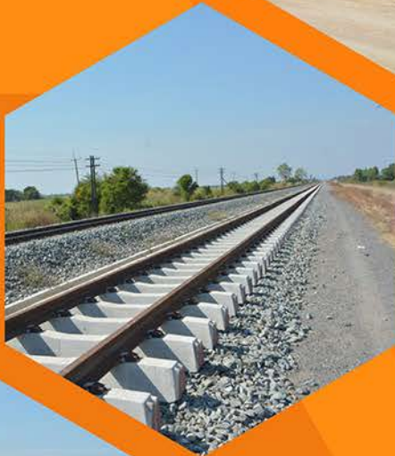
งานก่อสร้าง ทางรถไฟ
