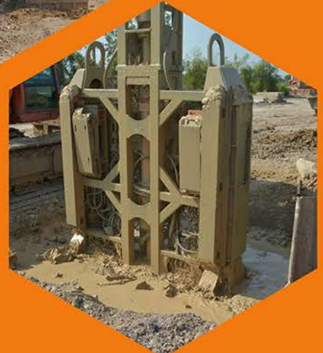
งานเสาเข็มเจาะ แบบเหลี่ยม
