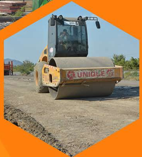
งานบดอัดดินคันทาง
