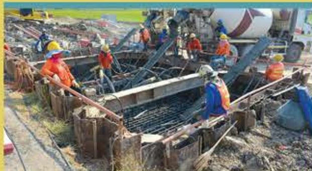
งานก่อสร้างฐานราก
