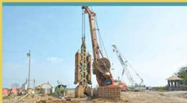
งานเสาะเก็บเจาะแบบเหลี่ยม
