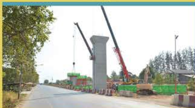
งานติดตั้งเสาทางวิ่งรถไฟยกระดับ
