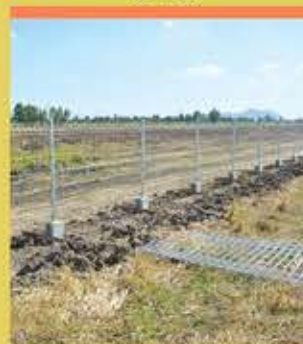
งานติดตั้งรั้ว
