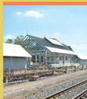
งานก่อสร้างสถานีรถไฟ
