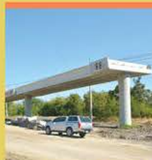
งานก่อสร้างสะพานข้ามทางรถไฟรูปตัวยู
