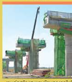
งานก่อสร้างสะพานข้ามทางรถไฟ
