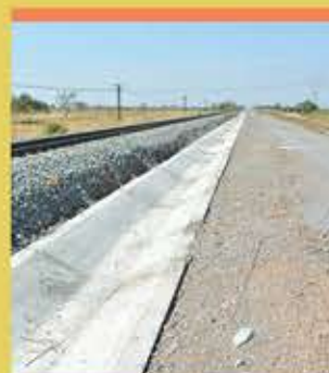
งานก่อสร้างท่อและทางระบายน้ำ
