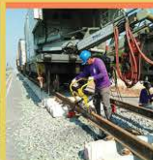
งานก่อสร้างทางรถไฟ
