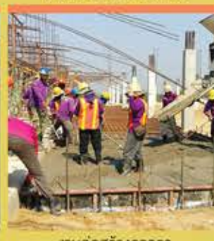
งานก่อสร้างอาคารศูนย์ควบคุมการเดินรถไฟ
